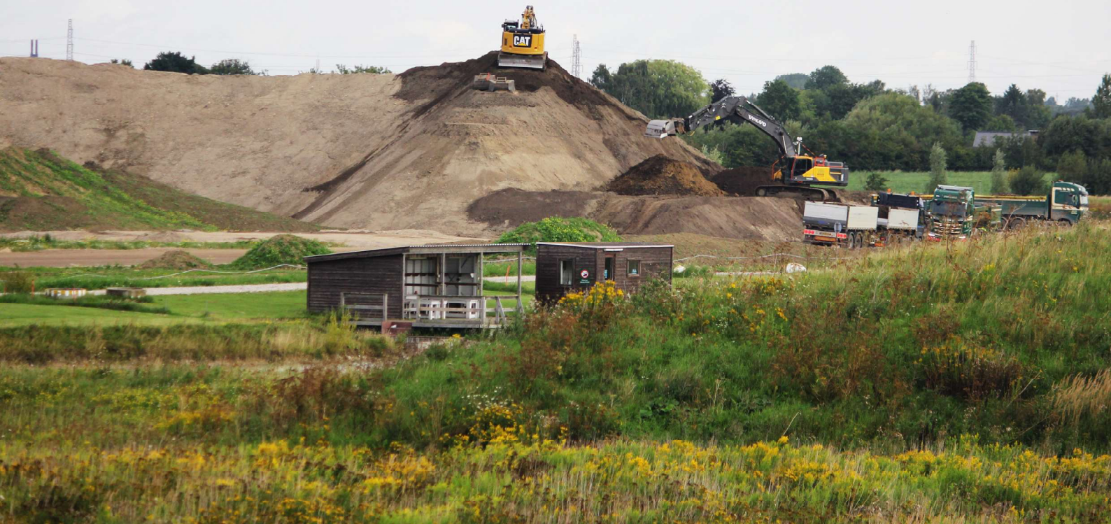
Opbygningen af bakkelandskab som fungerer som støjvold ved Tværhøjgård
